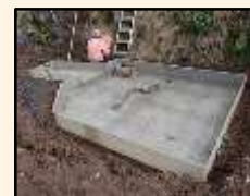
防水はFRPにて行います。
