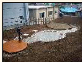
施工地 北海道小樽市
