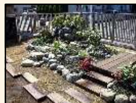
施工地 埼玉県
