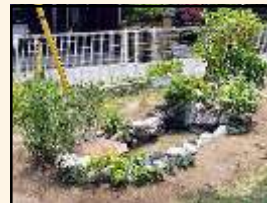
施工地 石川県
