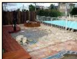
施工地 茨城県
